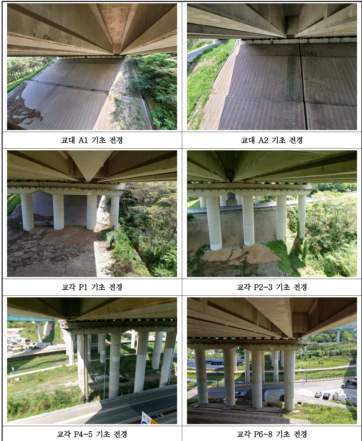
【사진 38.3.12】 기초 전경
