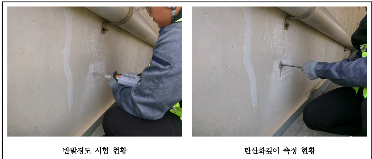
【사진 38.4.1】 콘크리트 내구성조사 현황
