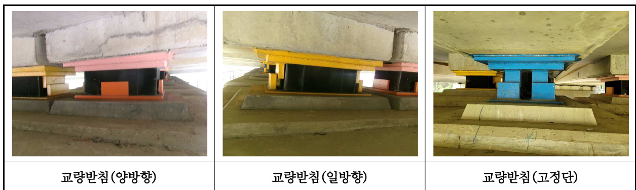
【사진 38.3.13】 교량받침 전경
