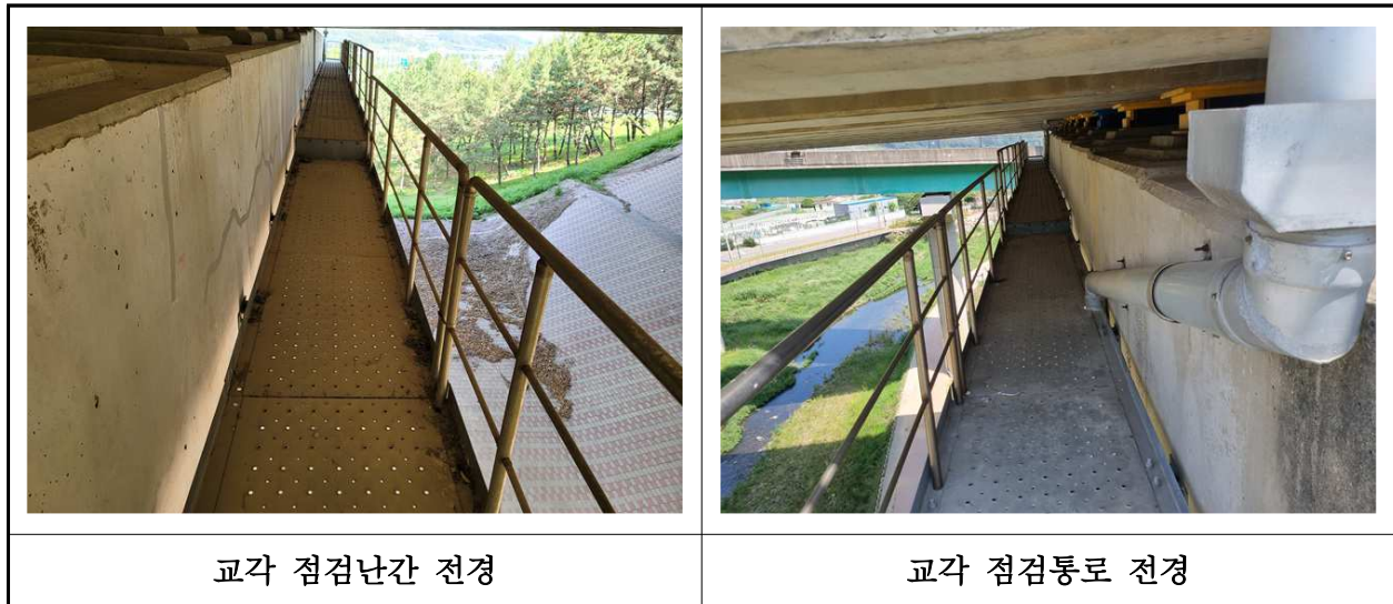
【사진 38.3.26】 교량 점검시설 전경
