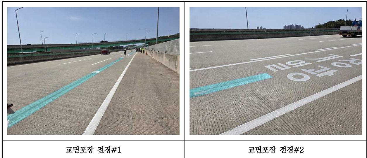
【사진 38.3.20】 교면포장 전경
