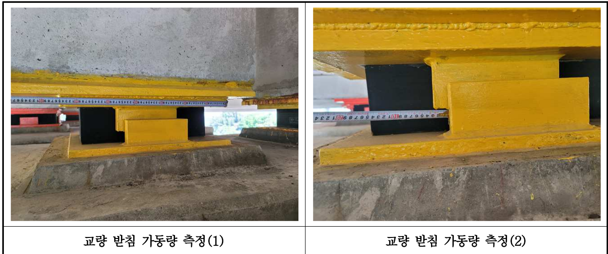
【사진 38.3.16】 교량받침 이동량 측정
