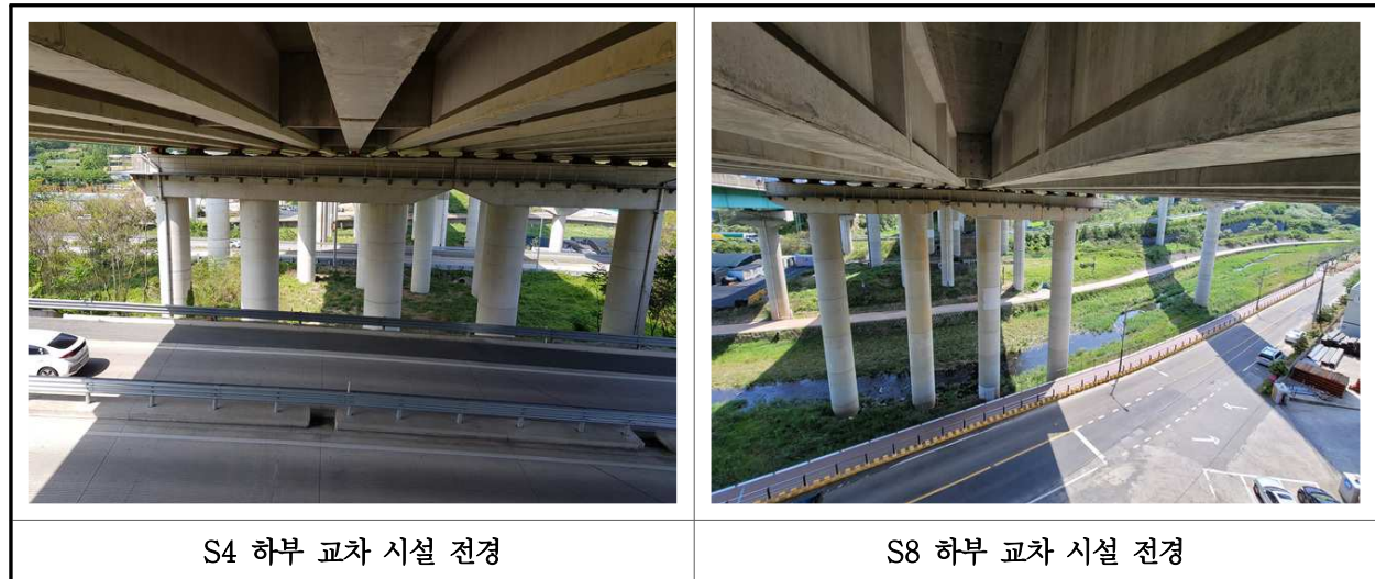
【사진 38.2.1】 주변환경 및 하중변화 전경(계속)
