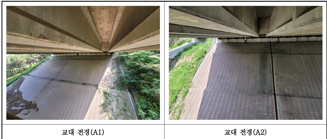
【사진 38.3.8】 교대 전경
