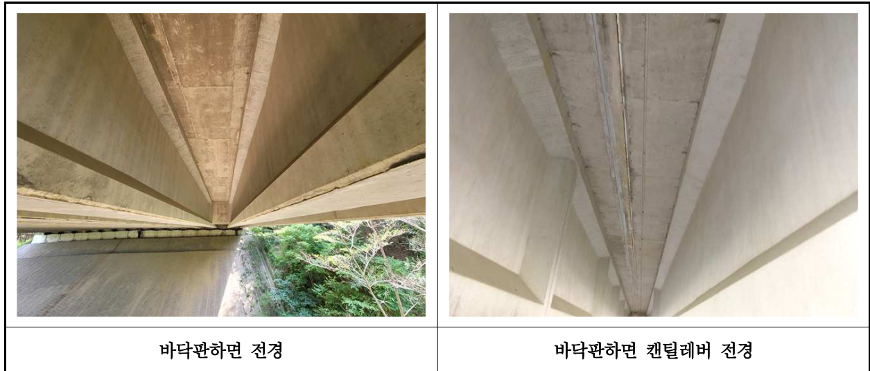
【사진 38.3.2】 바닥판하면 전경
