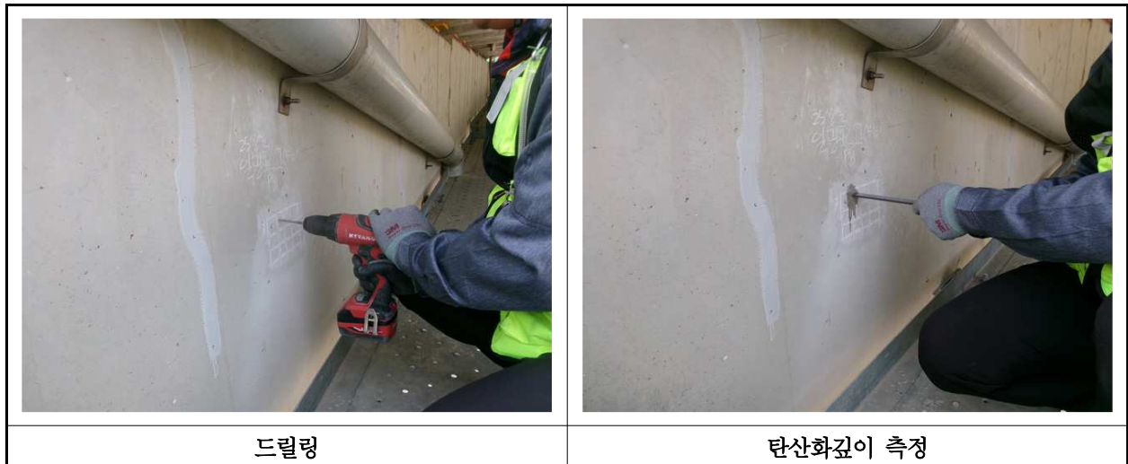
【사진 38.4.3】 탄산화 깊이 측정 현장사진
