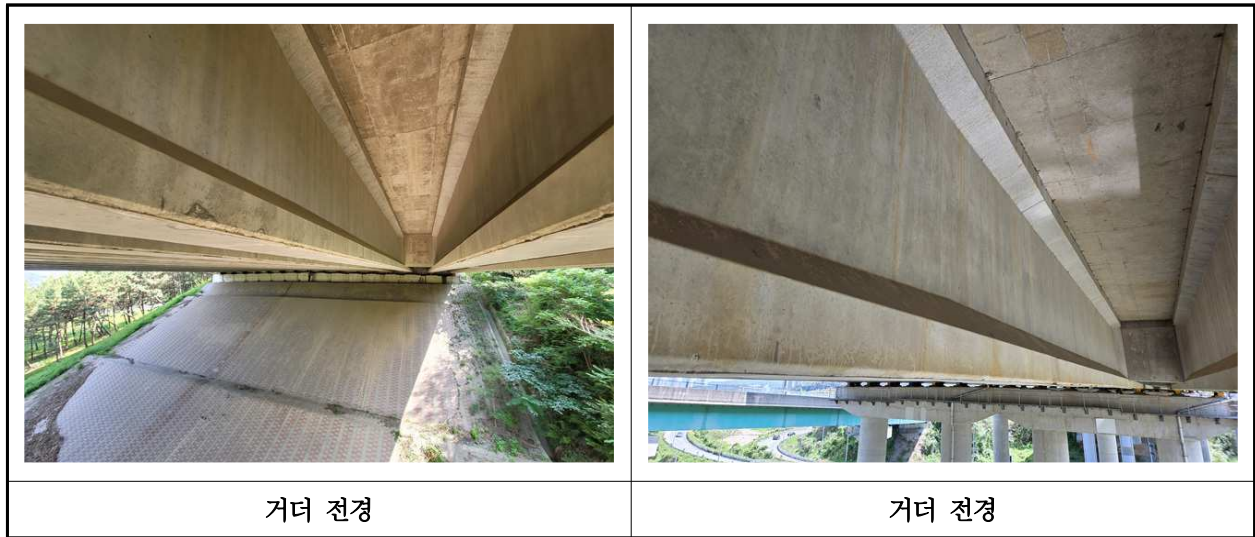
【사진 38.3.4】 거더 전경
